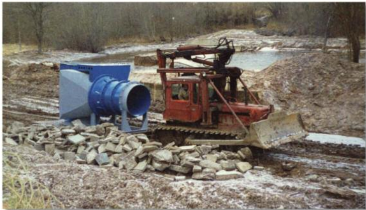
Transport turbíny MVE Gudaj (Litva) Transport of turbine for hydro power plant Gudaj (Lithuania) Перевозка турбина МГЭС Гудай (Литва)
