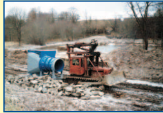
• Transport a montáž turbíny MVE Gudaj - Litva
