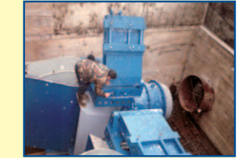
• Transport a montáž turbíny MVE Gudaj - Litva
