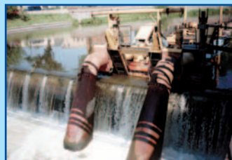
• Plovoucí elektrárny s turbínami Sigma 750 a Banki 600/1200
