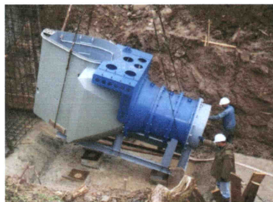
USAZOVÁNÍ KOMPLETNÍ TURBINY NA STAVBĚ
