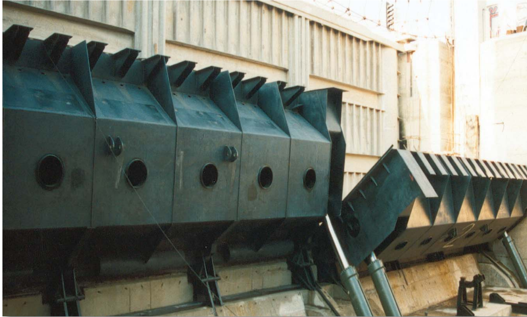
Klapková vrata pro plavební komoru Gabčíkovo (Slovensko) Tilting gates for upstream nose of Gabčíkovo lock chambers (Slovakia) Клапаны шлюза Габчиково (Словакия)
